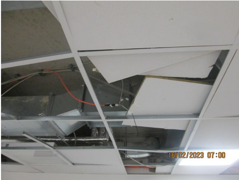
Zerstörte Decke in einer Umkleidekabine der Gymnasialsporthalle
